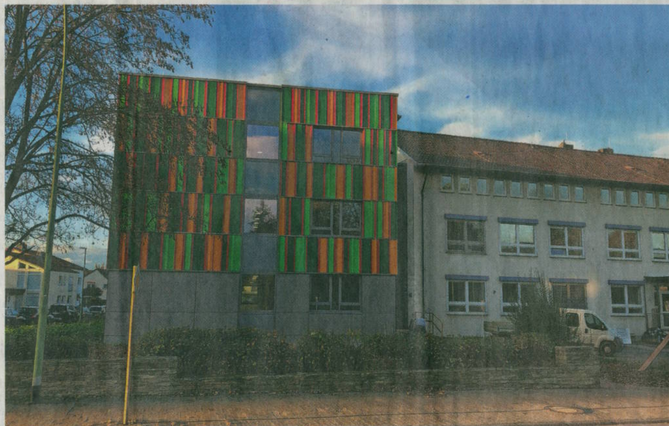
Rot-grün: „Haus der Umwelt“ wird der neue Anbau der Kreisverwaltung genannt.
